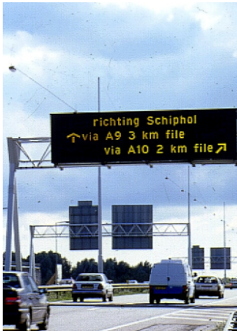
Figuur 1: Links (met dank aan Peek Traffic B.V.): Een DRIP toont de filelengtes of reistijden voor de alternatieve routes naar een bepaalde eindbestemming. Rechts: Toeritdosering bij de A13 in Delft.
